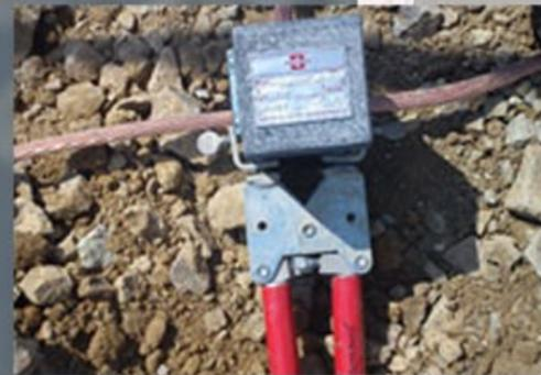
Suministro, instalación y puesta en servicio del sistema de puesta a tierra a nivel general y para subestación de 3MVA, 13200V en el edificio Coform en Papeles del Cauca, e interconexión de la puesta a tierra de la subestación con la subestación principal de 115kV. Elaboración de malla y colas para los motores y equipos especiales en cable de cobre calibre 4/0 AWG desnudo con soldadura exotérmica y varillas de cobre-cobre de  $\varnothing$  5/8in x 2.4m. Cliente: Papeles del Cauca S.A.
